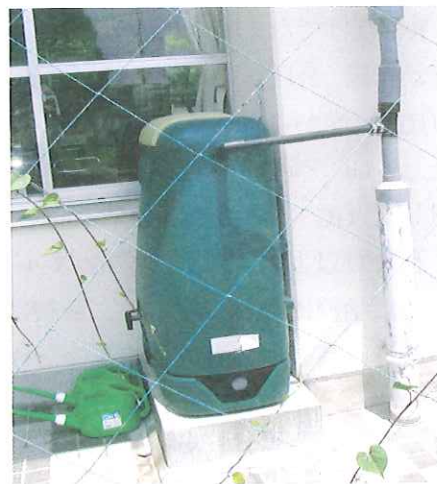
図 10. 屋上に降った雨水を容器に蓄えておき、晴天時の給水に利用できるようにした城西中
