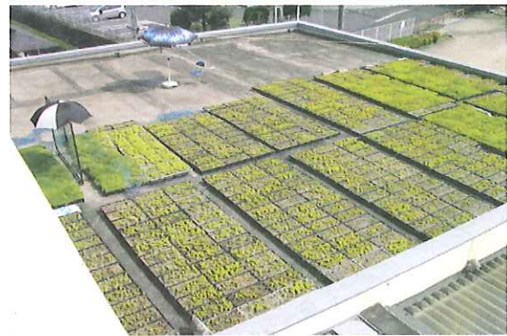
図3. 校舎の屋上緑化のため①室の上に並べたメキシコマンネングサの容器（手前）と設置してない半分から向こう側（③室の上）
