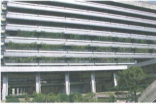
図2. 県庁舎のベランダに設置した朝顔とニガウリによるグリーン・カーテン
