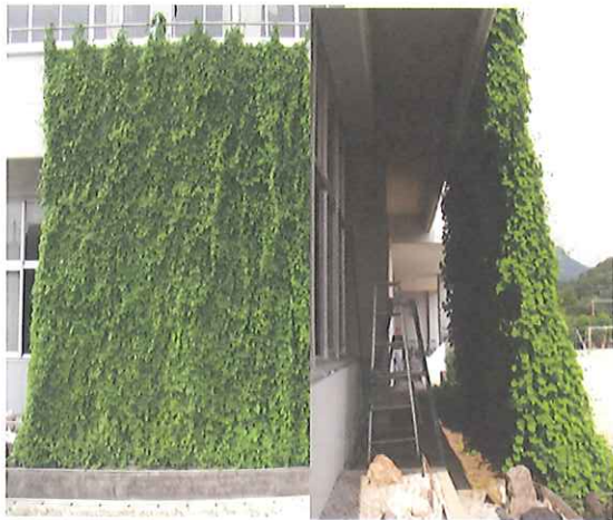
図6 右：正面からだとても非常に良く繁茂し見事である。室内温度も2-3℃下がる。左：側面から見ると室内が暗く照明が必要となり、更に通風が悪い。
