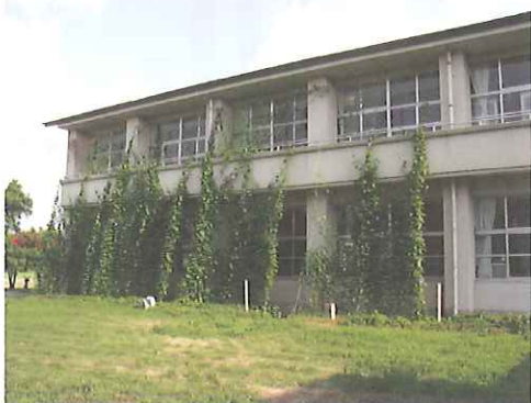
図2 下:GC 効果測定のための3教室（実際には写真右側のGCを降ろし、「GCなし」の対象教室として使用した） 上:室内から見た測定対象教室のGC
